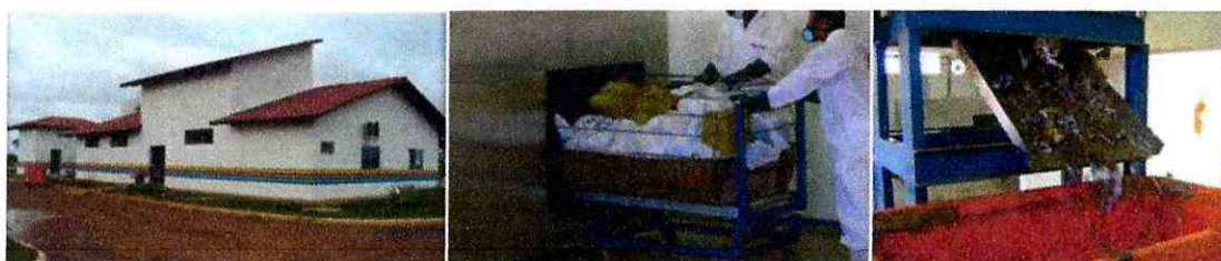
Figura 22 – Central de Tratamento de RSS, autoclave e descaracterização dos resíduos.
