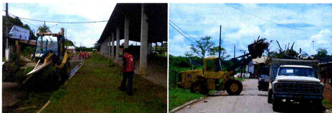
Figura 10 – Serviços executados na “Ação de Inverno”.
