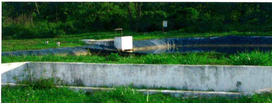
Figura 14 – Lagoa de tratamento do Aterro Sanitário localizada na UTRE.
