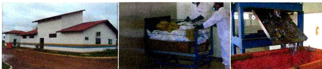
Figura 12 – Central de Tratamento de RSS, autoclave e descaracterização dos resíduos.
