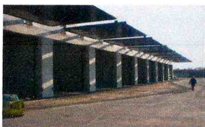
Biodigestão em túneis
